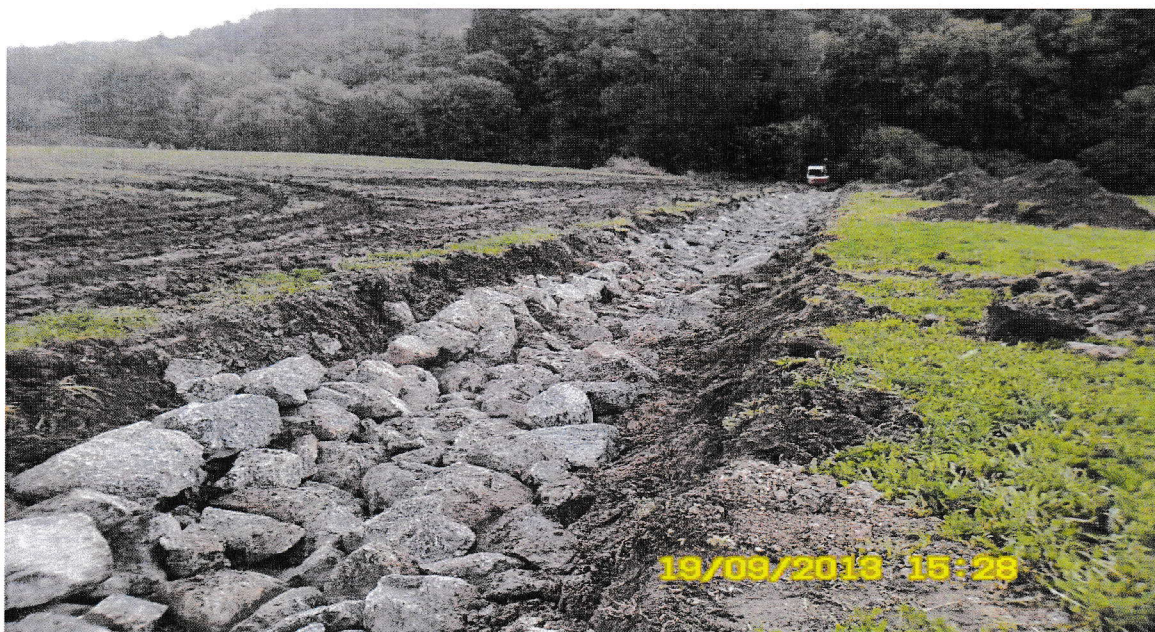
Stavba záchytného příkopu v k.ú. Svatá
