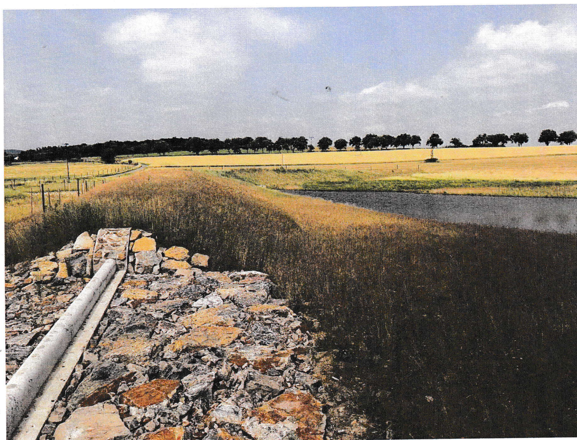
Výstavba suchého poldru v k.ú. Kublov (zachycení vody v krajině, ochrana obce před přívalovými srážkami)
