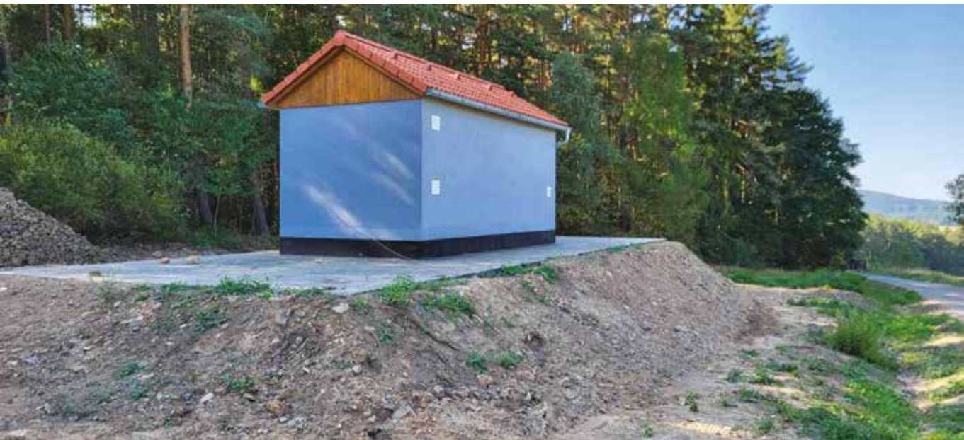
Vodojem na Kvani
